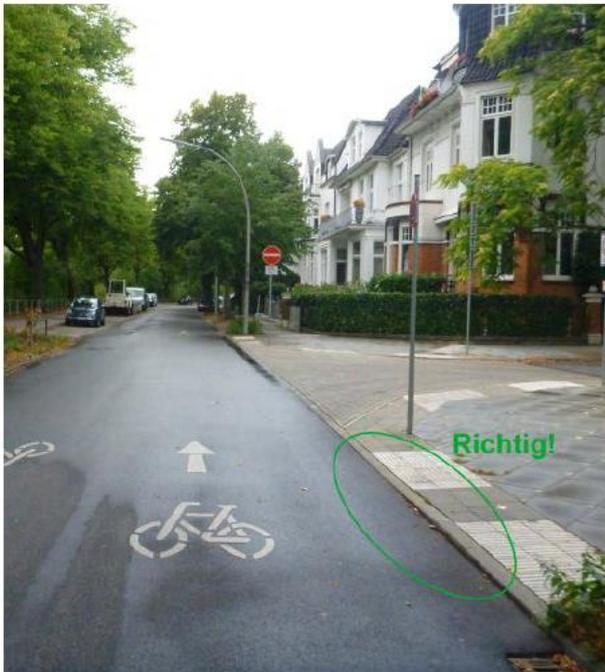
**Abbildung 22:** Korrekte Ausbildung einer Gehwegüberfahrt in Hamburg. Der Bordstein verläuft durchgehend parallel zur bevorrechtigten Fahrradstraße (Leinfad/Mövenstraße).
